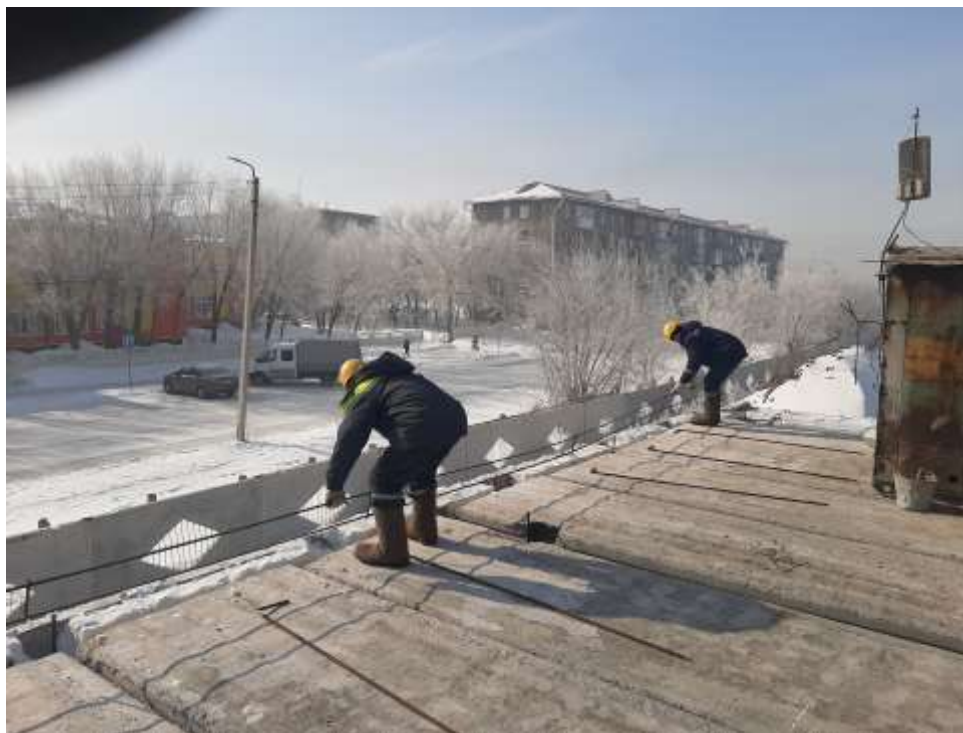
Рисунок 7 – Армирование швов плит перекрытий
