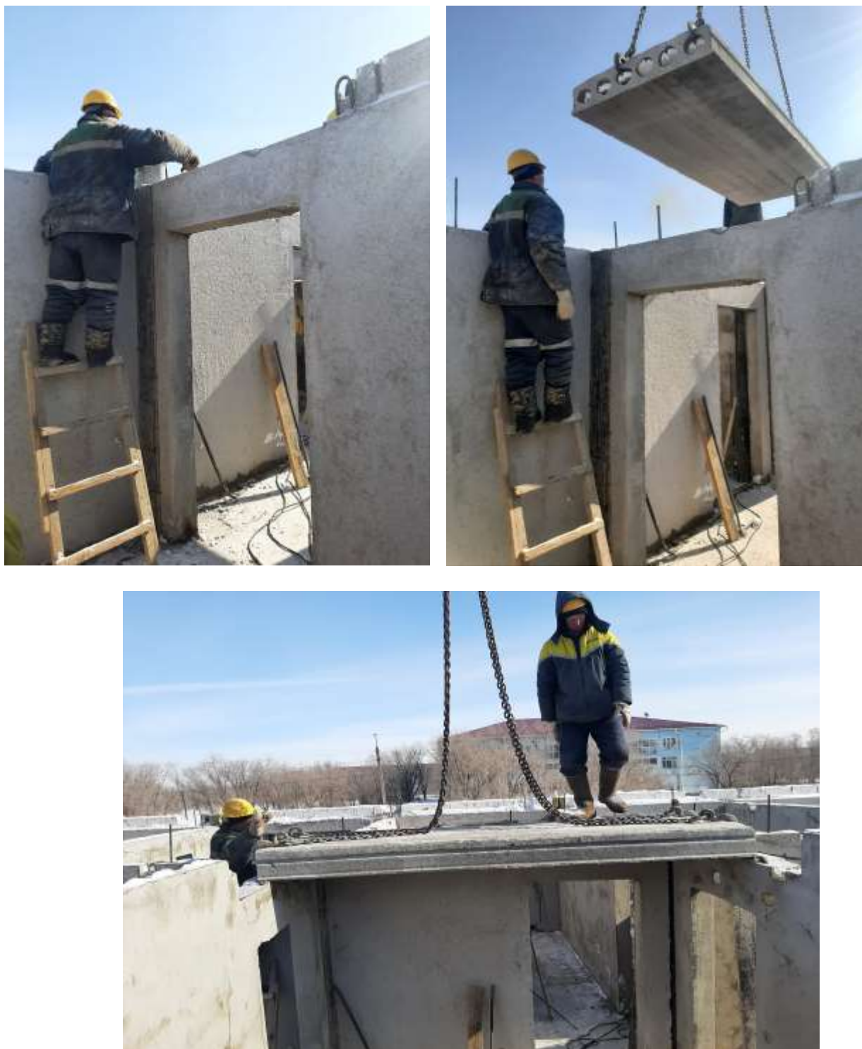
Рисунок 6 – Монтаж плит перекрытий
