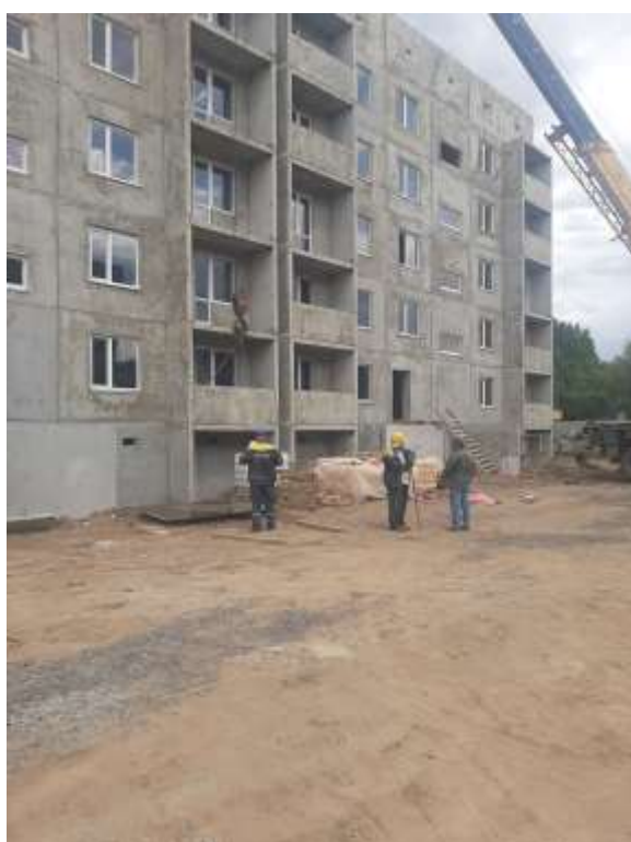
Рисунок 5 - Установка панели стенок и плит лоджий
