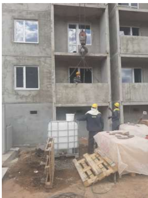
Рисунок 5 - Установка панели стенок и плит лоджий
